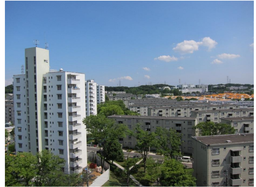
多摩ニュータウン一次入居地区の現在(永山)
